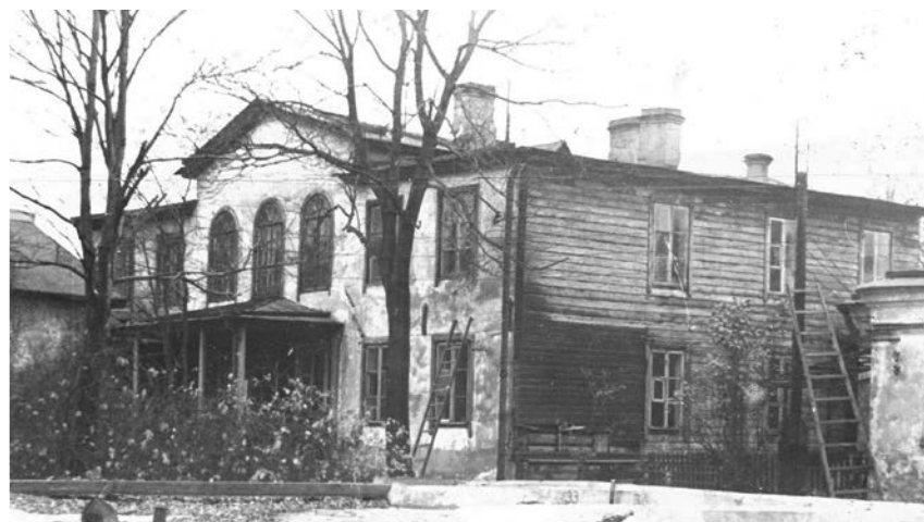
Здание бывшей гидроэлектрической лаборатории (ГЭЛ)
