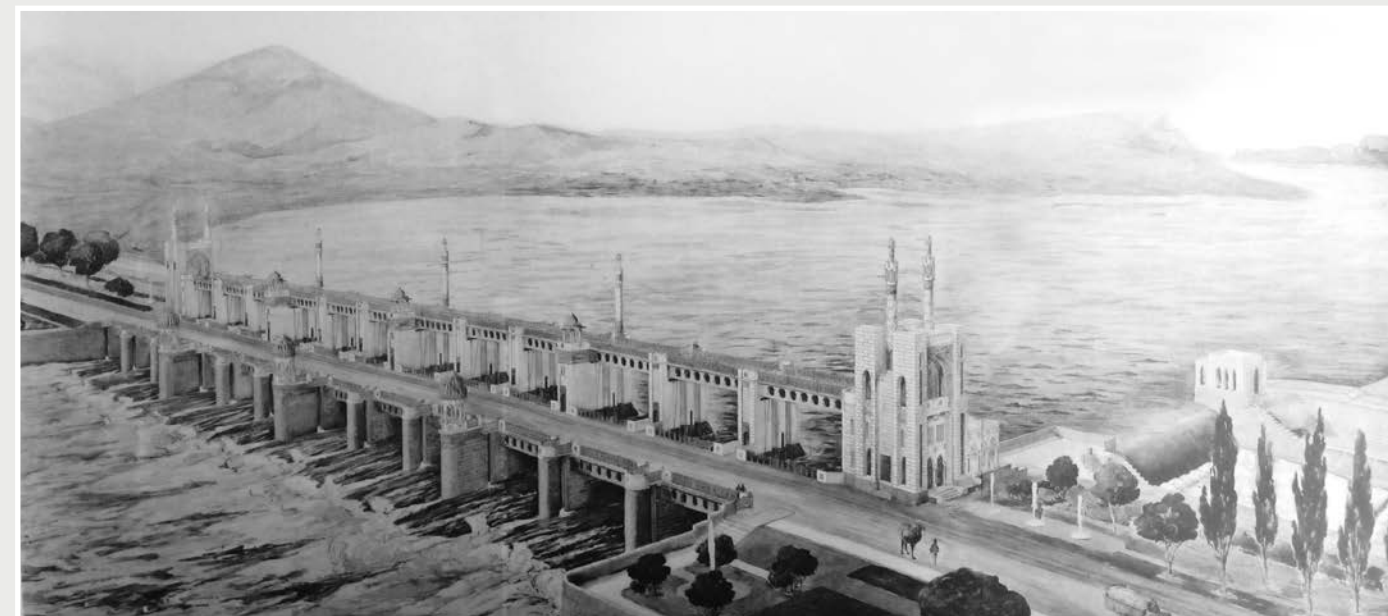
Главные сооружения голодностепской оросительной системы по проекту Г. К. Ризенкампфа
