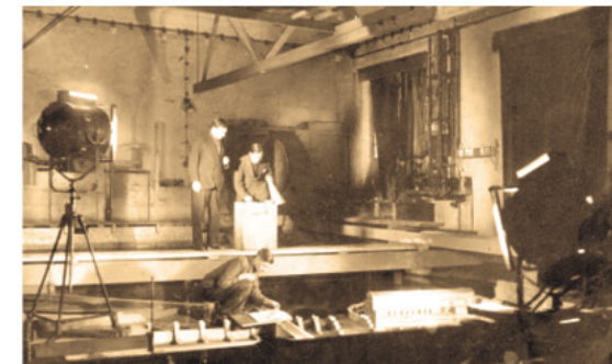
Подготовка модели Нижне-Свирской ГЭС к исследованиям пропуска строительных расходов.
